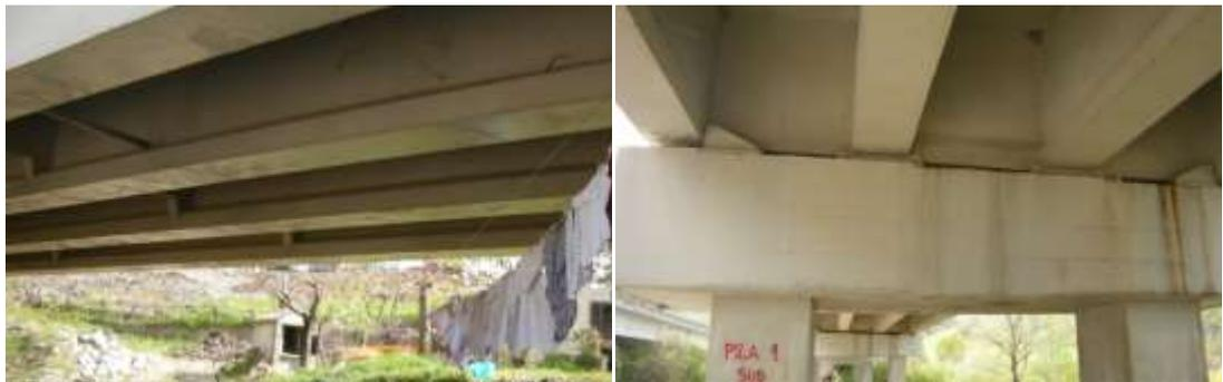
Figure 2. Pian della Menta viaduct deck intrados before retrofit.
