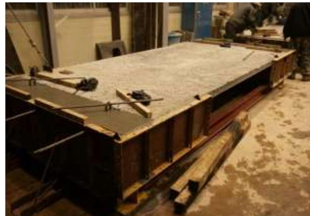
(d) Placing of UHPC in joints
