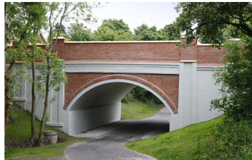
(d) Finished bridge (December 2012)
